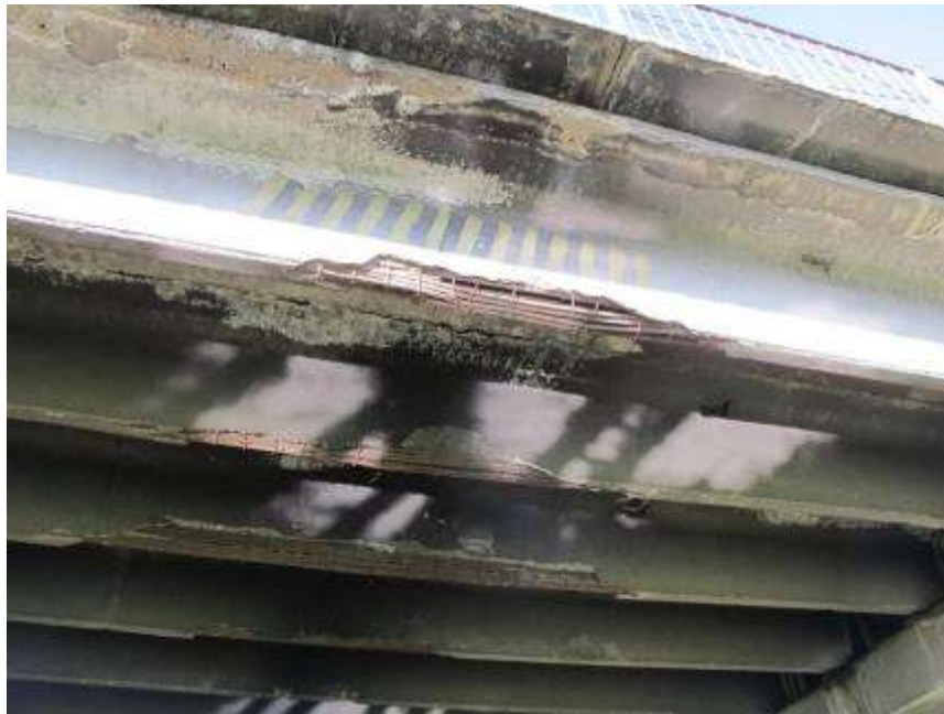
1-Rasm. Oraliq qurilmalar ichki qismlarida nuqsonlarning shakllanishi
